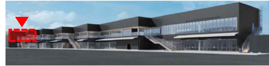
リングサイドマーケットプレイス西 2階 (建物の西側奥に入り口) EXPOサロン
