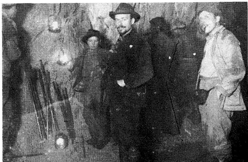
シンフロン・トンネルの建設工事現場
